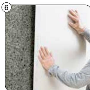
Simfofit® doit toujours être recouvert avec des plaques de plâtre de 12,5 mm minimum pour répondre aux exigences de sécurité incendie.
