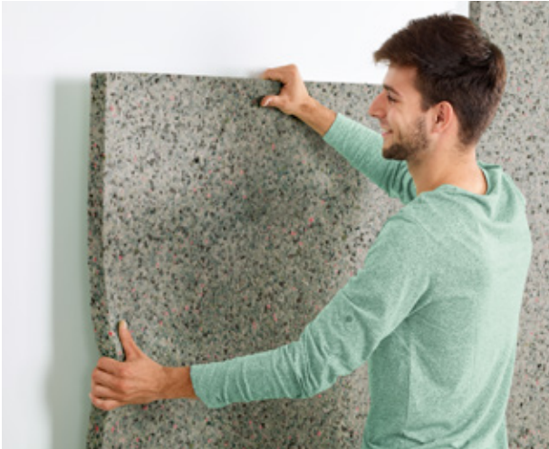
Positionering van de panelen alvorens ze te verlijmen.
