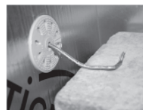
Replier éventuellement l'ancrage du mur.
