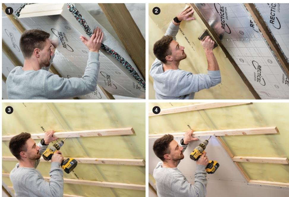
Poussez les plaques entre les chevrons, posez la protection contre la vapeur et l'air, fixez le bois entre la structure et appliquez la couche de finition (p. ex. plaques de plâtre).
