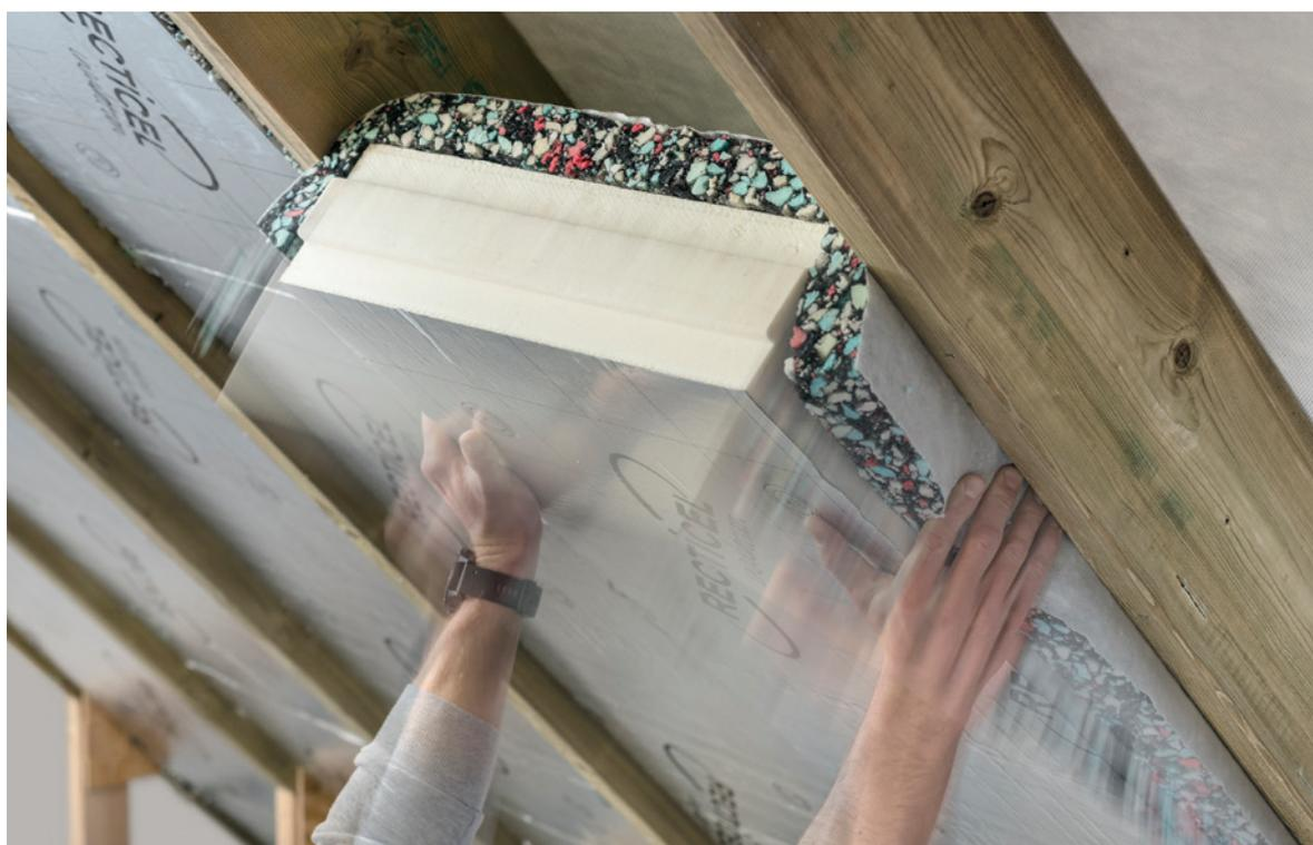
Les panneaux sont pourvus d'une languette et d'une rainure sur les côtés courts, le but étant de les monter proprement pendant l'installation, afin d'assurer un fonctionnement parfait du système.
