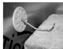
Eventueel omplooiën van het spouwanker.
