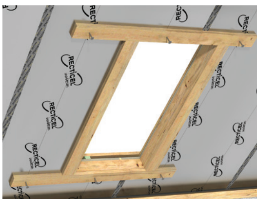
Figuur 12: bijkomende versteviging langs de binnenzijde
