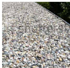
Losliggend met ballast
