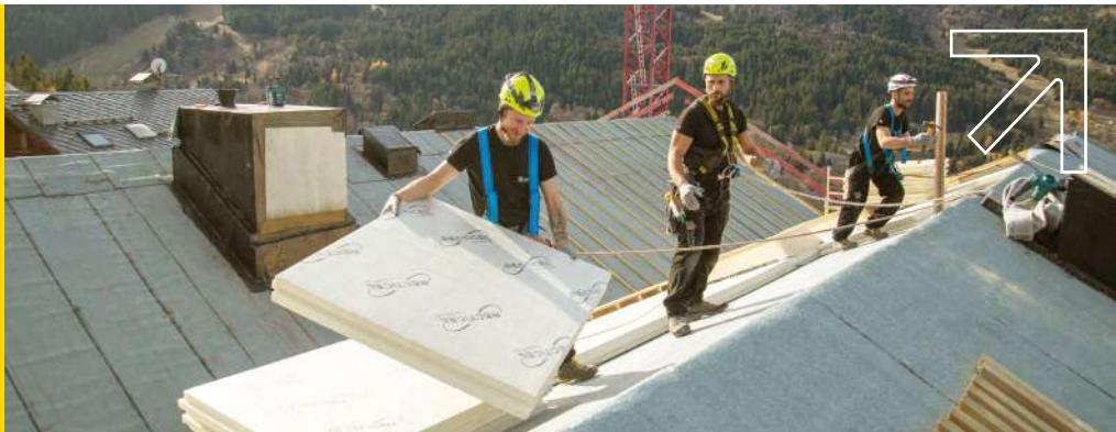
Notre procédé montagne est validé par un ETN d'Alpes Contrôles, qui encadre précisément la mise en œuvre en altitude. Sur un chantier comme Méribel, avec une toiture inclinée et des contraintes de hauteur, Eurotoit® Montagne facilite concrètement la pose : le panneau est léger, son format 1 200 × 1 000 mm simplifie la manutention, et son parement antidérapant et anti-éblouissement sécurise les équipes. Des points essentiels pour garantir une mise en œuvre fiable sans perte de temps.
