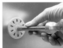
Inslaan van het spouwanker d.m.v. het slagpijpje tot aan de schotel.
