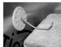
Eventueel omplooiën van het spouwanker.
