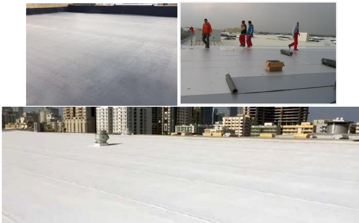
Rysunek 10: Pokrycia wodochronne syntetyczne 7 (u góry po lewej: EPDM; u góry po prawej PVC; na dole TPO)
