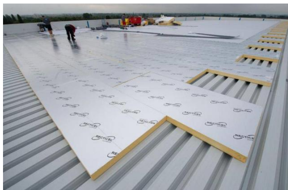
Rysunek 22: Usytuowanie płyt izolacyjnych na blasze trapezowej
