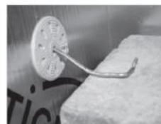
Eventueel omplooiën van het spouwanker.
