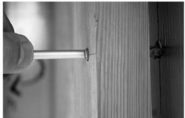
les chevrons pendre "librement" afin de pouvoir les aligner parfaitement par la suite. Les joints entre les lattes de bois doivent être alternés les uns par rapport aux autres, afin d'assurer un recouvrement entre les joints.
