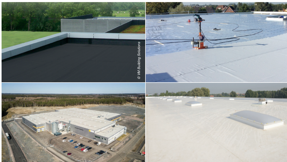
Afbeelding 10, 11, 12 en 13: Synthetische dichtingssystemen (boven links: EPDM, boven rechts PVC; Links onder: PVC; Rechts onder: TPO)
