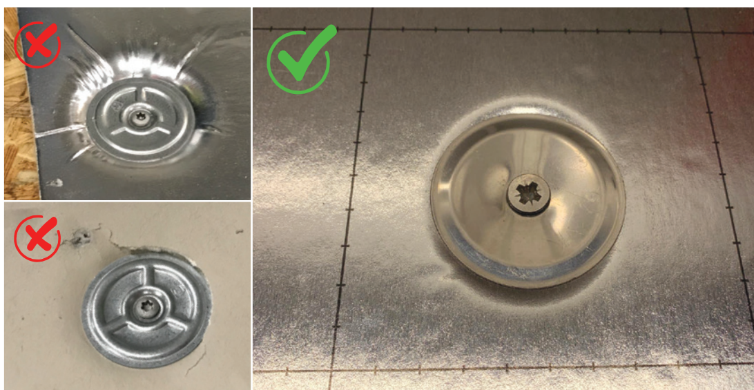
Afbeelding 25, 26 en 27: Mechanische bevestiging van isolatieplaten (Links: niet toegestaan; rechts: correcte bevestiging)
