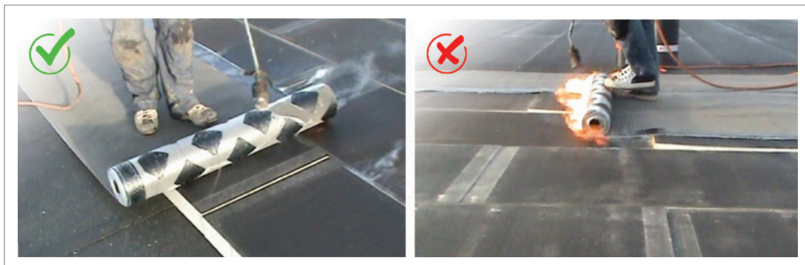
Afbeelding 32 en 33: Aanbrengen van waterdichting met brander op Eurothane Bi-4-platen (Links: Branden op de waterdichtingsrol (gedeeltelijk hechtend membraan); rechts: branden op isolatieplaat)
