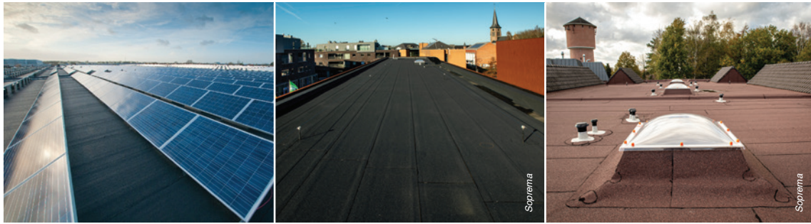
Afbeelding 7, 8 en 9: Bitumineus dichtingssysteem
