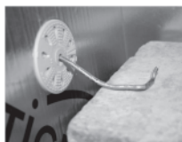
Replier éventuellement l'ancrage du mur.
