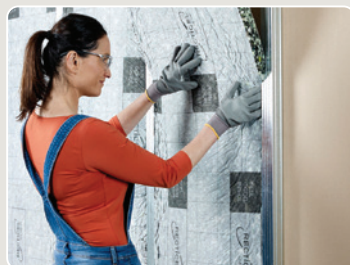
Instalación rápida entre los montantes metálicos
