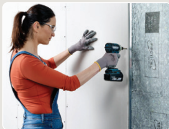
Cubrir con una placa de yeso según las instrucciones de instalación del proveedor
