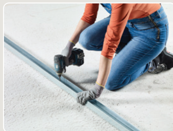
Instalación de los perfiles metálicos del tabique divisor
