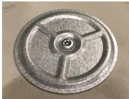
8 8 Izoliacinių plokščių mechaninis montavimo būdas (viršuje: neteisingas; apačioje: teisingas tvirtinimas)
