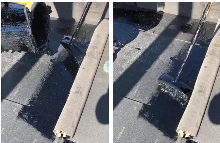
16 16: Hidroizoliacinės membranos tiesimas ant izoliacinių plokščių – karšto bitumo paskleidimas.
