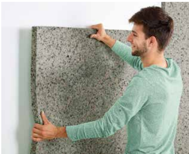
Positionnement des panneaux avant de les encoller.
