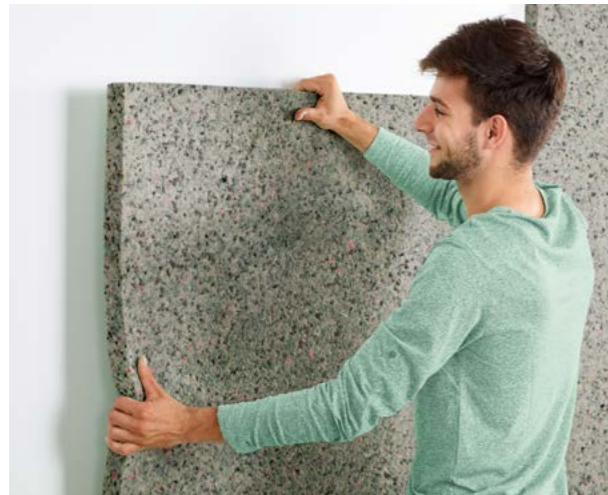
Positionnement des panneaux avant de les encoller.
