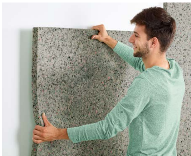
Positionnement des panneaux avant de les encoller.
