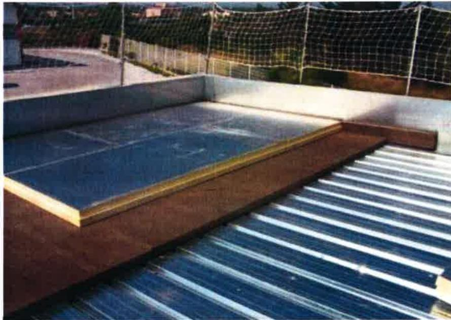
**Nota :** l'écran thermique Fesco C (3) peut être remplacé par un écran laine de roche 60 mm dans les croquis de mise en œuvre ci-dessus
